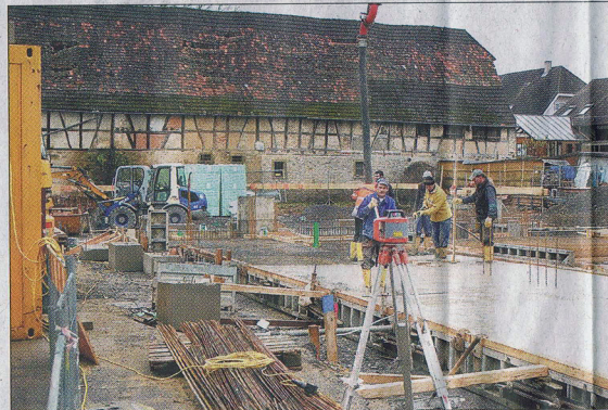
Mitten im alten Dorfkern wächst eine betreute Seniorenwohnanlage aus der Baugrube. Im März 2019 sollen 23 Wohnungen bezugsfertig sein. Foto: Weis
