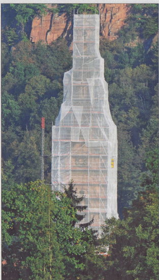
Christo lässt grüßen: Der mit Gerüst und Plastikplanen windfest „verpackte“ katholische Kirchturn im Herzen der Neckargemünder Altstadt vom Wiesenbacher Tal aus gesehen. Foto: Slogisnat
